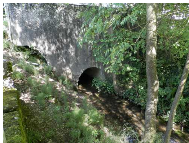
Franchissement de la voie communale du hameau de CHASSIN. On notera l'ouverture étroite du pont.
