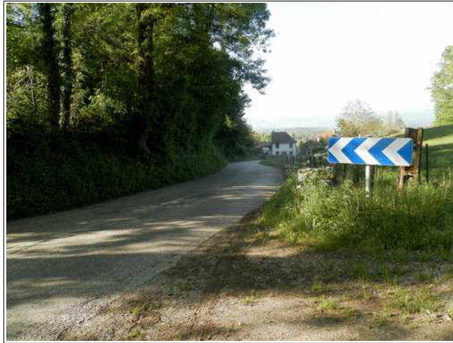
Axe d'écoulement au sud du bourg de PASSINS. L'eau peut se concentrer sur la RD244a puis atteindre le bourg.
