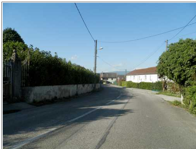
L'eau peut suivre la RD244a et se diffuser au niveau du bourg en empruntant divers passages.
